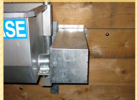
Mögliche Isolierung der Wasserleitung: HAASE-Schutzkasten S. 31
